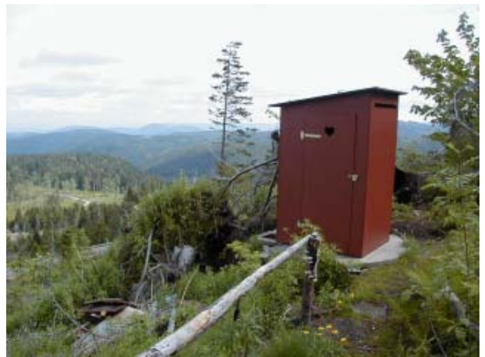
Bild: Toilettenhäuschen einer Wanderhütte mit undichtem Sammelschacht in der engeren Schutzzone einer Quelle
