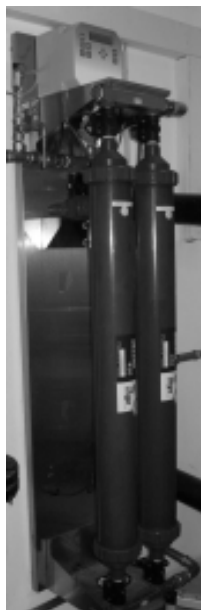
Bild: Beispiel für eine COP-Membrananlage mit 9 m 2 Membranfläche und die von ihr versorgte Siedlung mit 60 Einwohnern und einem Trinkwasserbedarf von 4.000 m 3 /a
