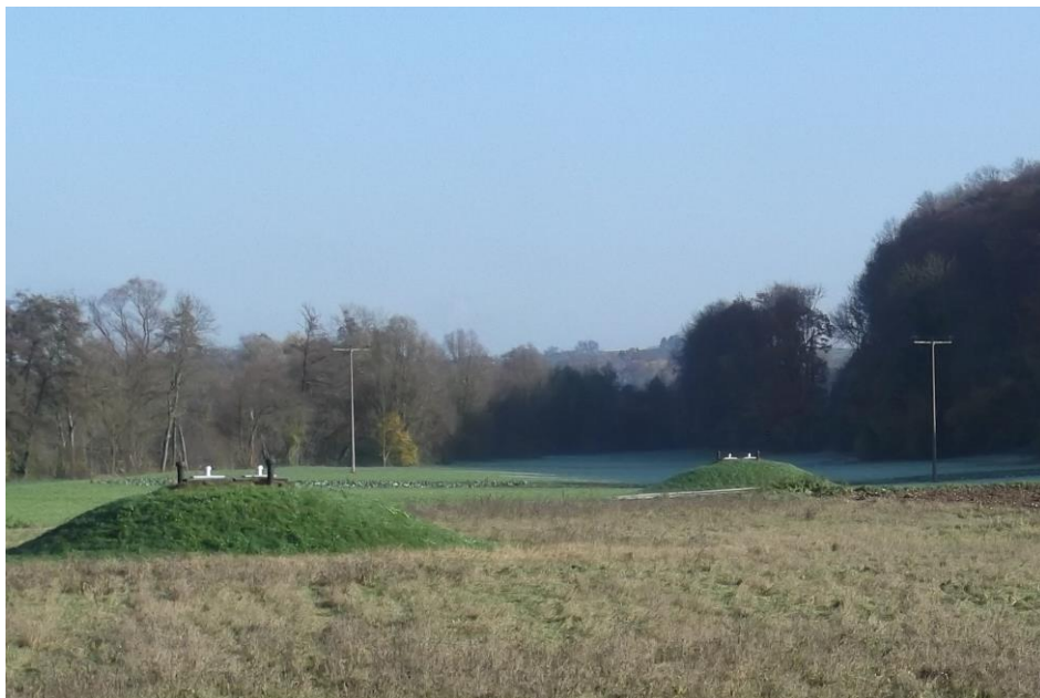
Brunnen der Trinkwasserversorgung
