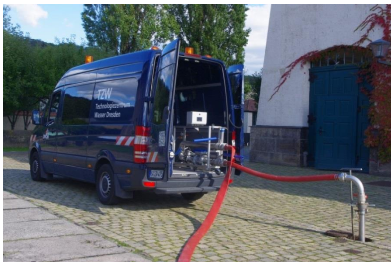
Bild 1: Mobiler Spülstand des TZW im Einsatz
