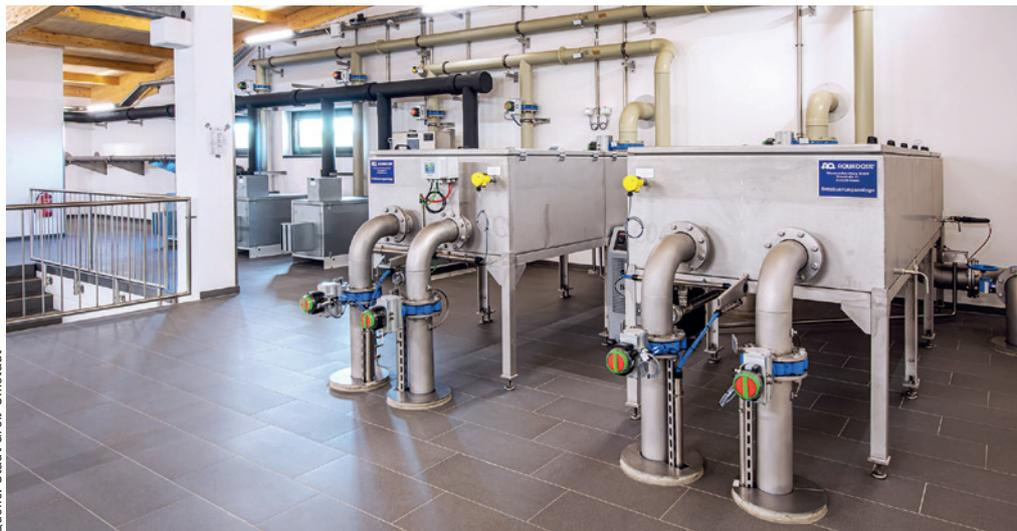
Abb. 4: Entsäuerung durch Flachbettbelüfter
