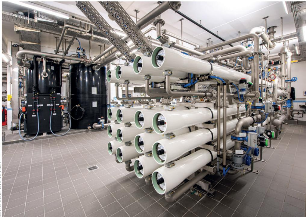
Abb. 3: Kompakt angeordnete zweistraßige Umkehrosmoseanlage
