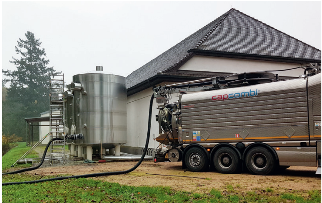
Abb. 4: Aktivkohlewechsel
