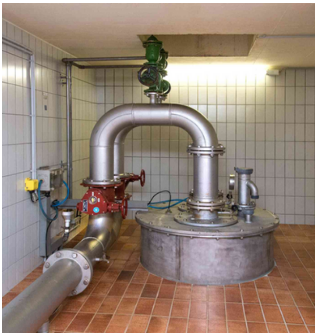
Abbildung 4: Brunnenstube eines Rohwasserbrunnens mit aktivem Entnahmebetrieb.
