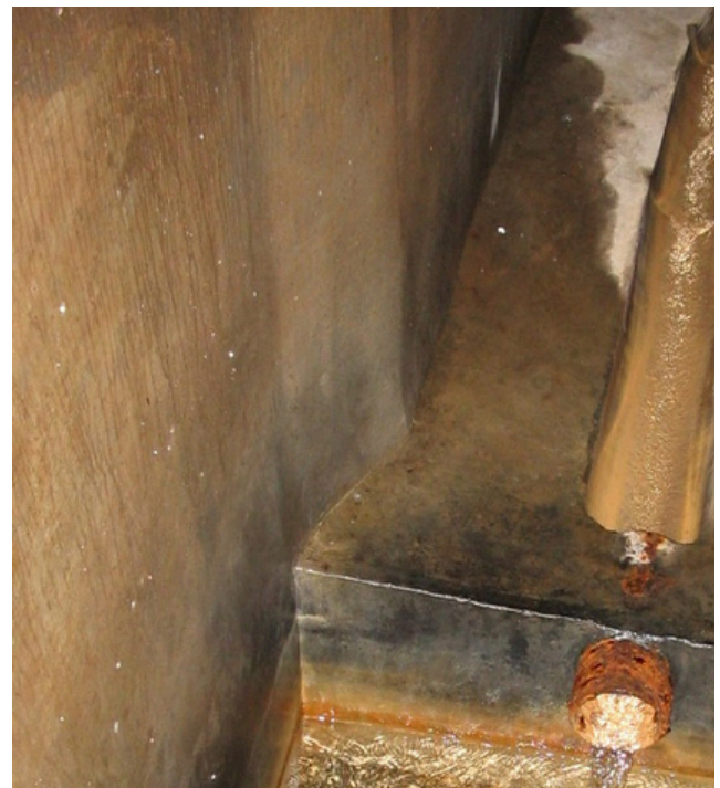
Abbildung 6: Eine gefasste Quelle mit Zulauf und Sammelbecken.
