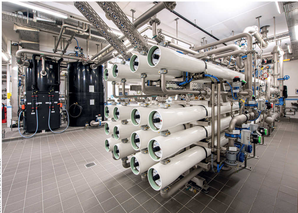
Abb. 3: Kompakt angeordnete zweistraßige Umkehrosmoseanlage
