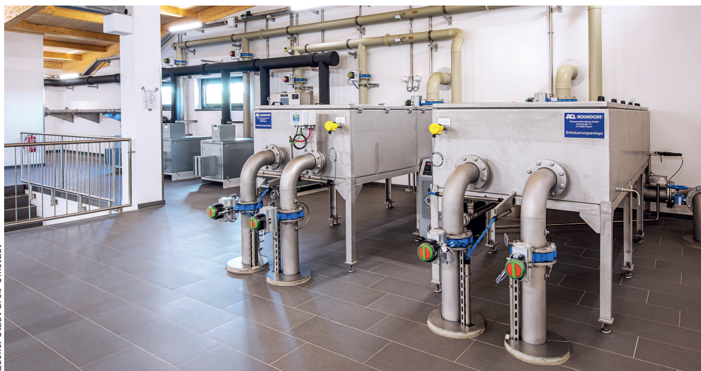
Abb. 4: Entsäuerung durch Flachbettbelüfter
