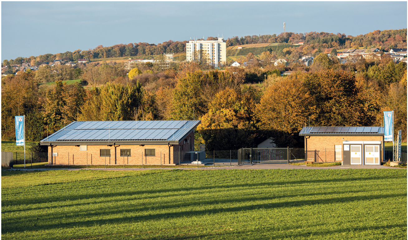
Abb. 2: Außenansicht des Wasserwerks in Groß-Umstadt
