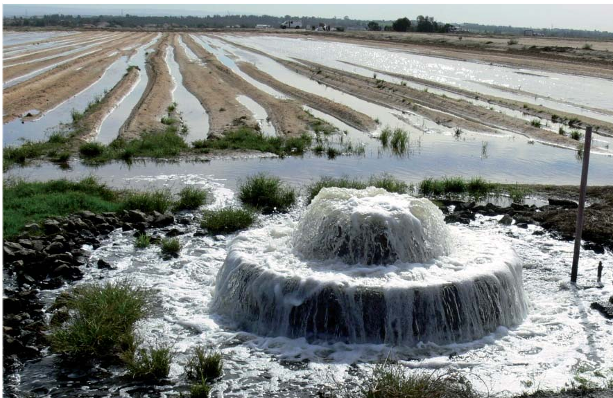
Versickerung von gereinigtem Abwasser auf einem Versickerungsfeld
