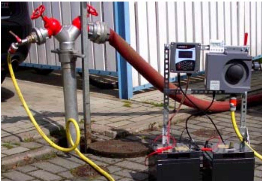
Bild: Untersuchung zur Erfassung der Sedimentbildung im Leitungsnetz
